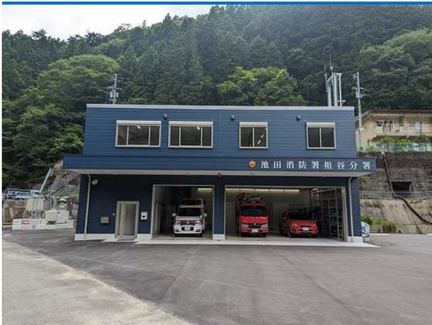
写真：令和5年4月供用開始した祖谷分署
