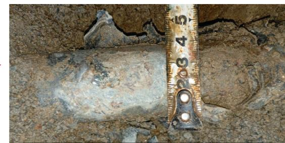
④ 配管拡大写真 (φ約 4cm、深さ約 25cm)
