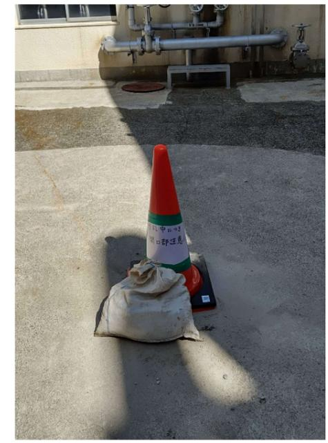
⑤ 掘削孔試掘後養生状況
