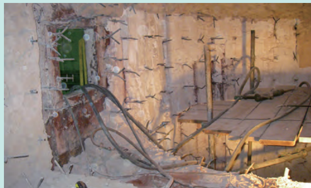
焼却炉内補修工事
