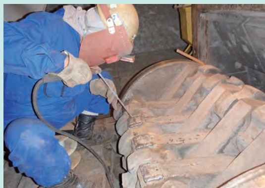
不燃ごみ処理施設整備工事
