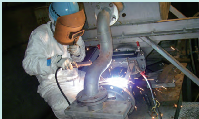
焼却施設機器整備工事
