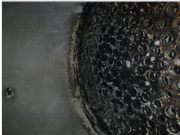
No. 24 その他設備 (熱交換器) 内部 上部 [伝熱管]
