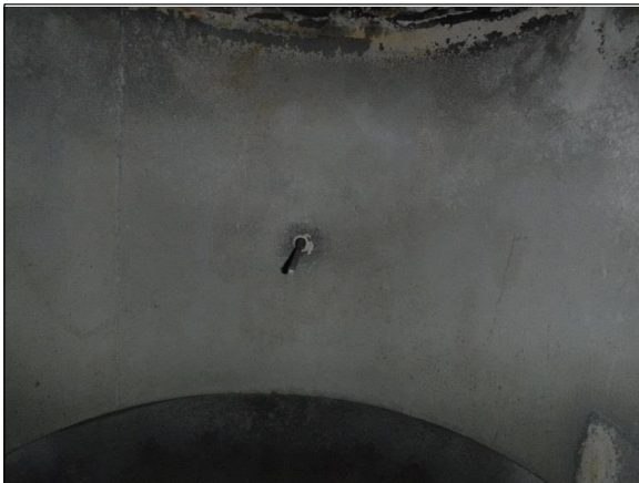
No. 23 その他設備 (熱交換器) 内部 側壁
