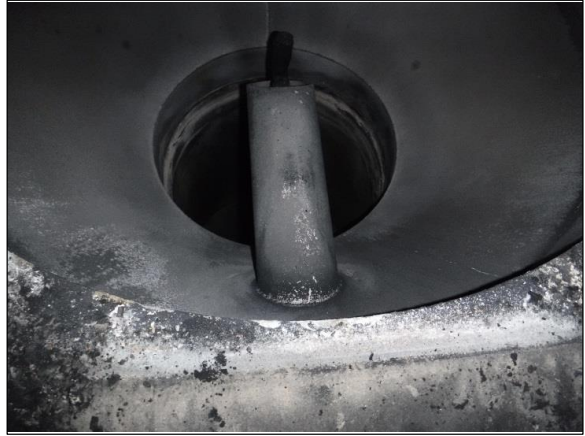
No. 26 その他設備（冷却塔） 内部 下部（ガス入口）
