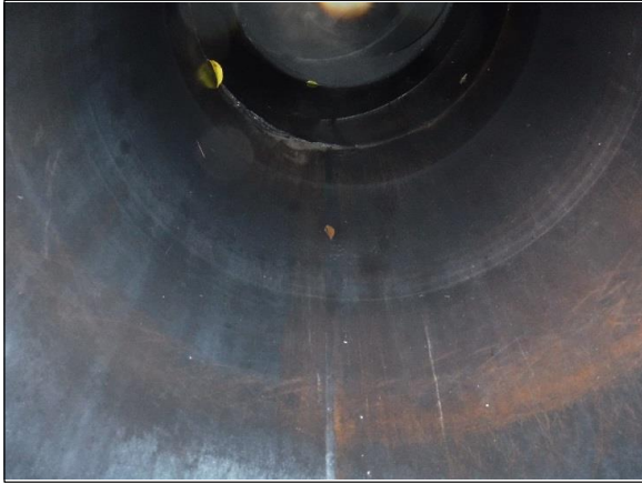
No. 13 煙突 内部 内壁
