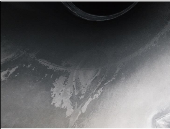
No. 27 その他設備（冷却塔） 内部 側壁
