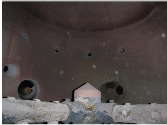
No. 4 し渣焼却炉 炉内部 側壁
