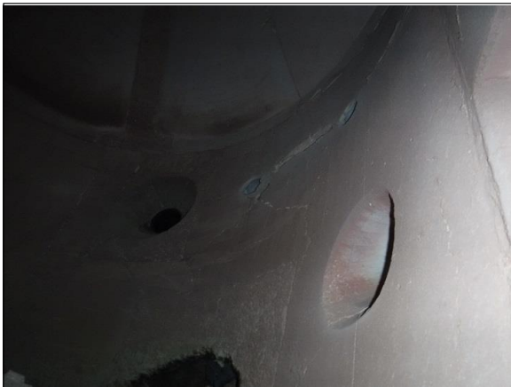
No. 5 し渣焼却炉 炉内部 側壁
