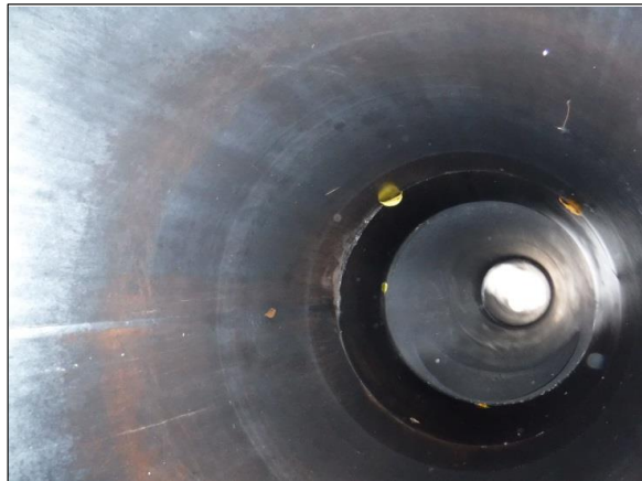
No. 12 煙突 内部 煙突下部より頂部を望む
