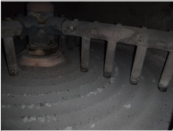
No. 3 し渣焼却炉 炉内部 炉床 ※炉内焼却灰有り
