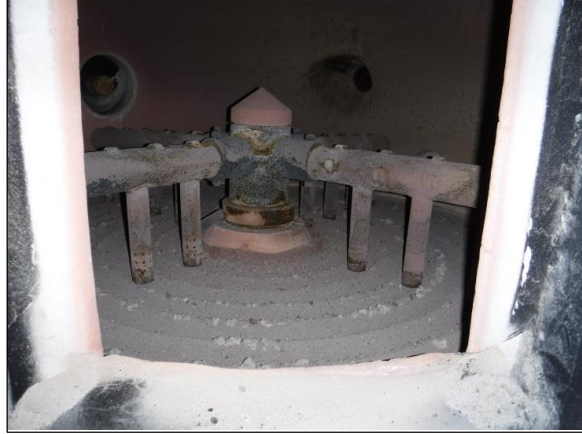
No. 2 し渣焼却炉 炉内部 炉床 ※炉内焼却灰有り
