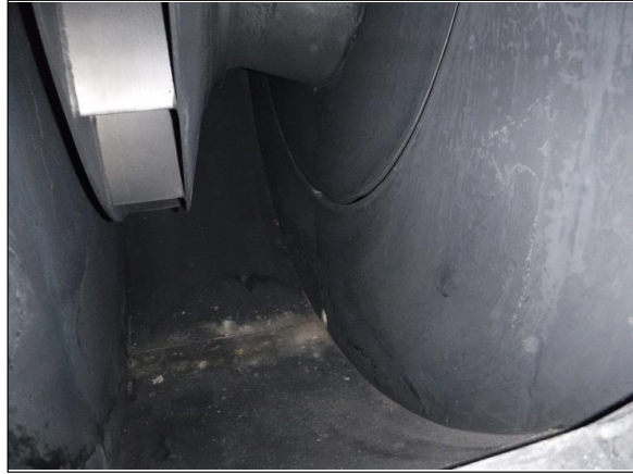
No. 8 煙道 (誘引ファン) ファン内部 ケース下部
