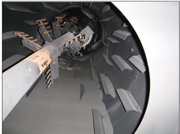
No. 30 その他（乾燥機） 内部
